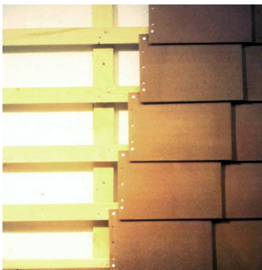
Abbildung 2: Mauerwerk mit Außendämmung und hinterlüfteter Wandbekleidung
