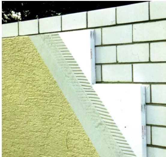
Abbildung 3: Wärmedämm-Verbundsystem
