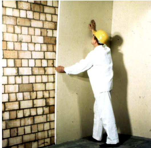
Abbildung 4: Innendämmung mit Verbundplatten
