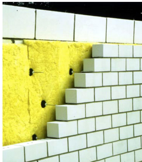
Abbildung 5: Zweischalige Außenwand mit Luftschicht und Wärmedämmung
